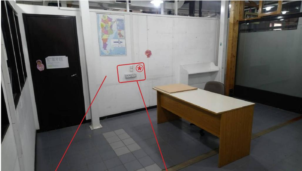
NOTA: PARA DEJAR LAS PAREDES EN CONDICIONES, SOLO SE DEJARÁN LOS TOMACORRIENTES EXSISTENTES, EL RESTO DE CABLEADO Y CABLECANALES QUE NO CUMPLAN UNA FUNCIÓN DETERMINADA DEBERÁN SER REMOVIDOS. LO MISMO PARA LA ESTANTERÍA COLGADA. \*
