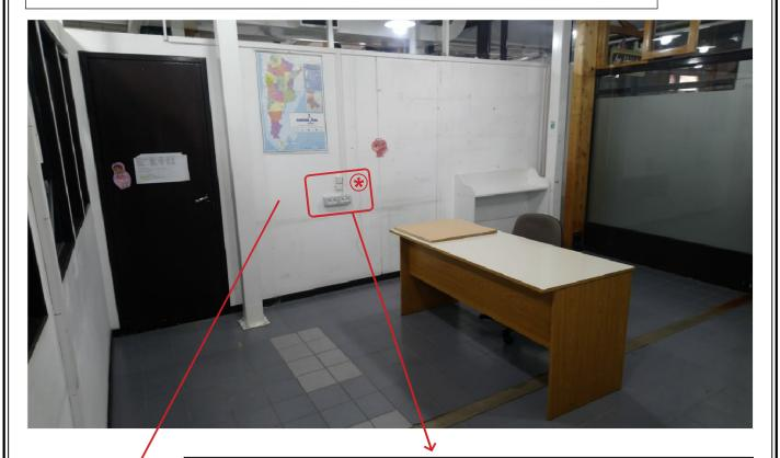
NOTA: PARA DEJAR LAS PAREDES EN CONDICIONES, SOLO SE DEJARÁN LOS TOMACORRIENTES EXSITENTES, EL RESTO DE CABLEADO Y CABLECANALES QUE NO CUMPLAN UNA FUNCIÓN DETERMINADA DEBERÁN SER REMOVIDOS. LO MISMO PARA LA ESTANTERÍA COLGADA.
