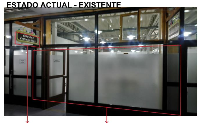
CARTEL EN PASILLO A MODIFICAR CON LA LEYENDA "ADMINISTRACIÓN -ATENCIÓN AL PÚBLICO EXTERIOR" EN VENTANAS EXISTENTES PUEDE OBSERVARSE LA PRESENCIA DE UN ADHESIVO TIPO "PAPEL CONTACT AUTOADHESIVO". EL MISMO DEBERÁ SER RETIRADO PARA GENERAR UNA SENSACIÓN DE TRANSPARENCIA.
